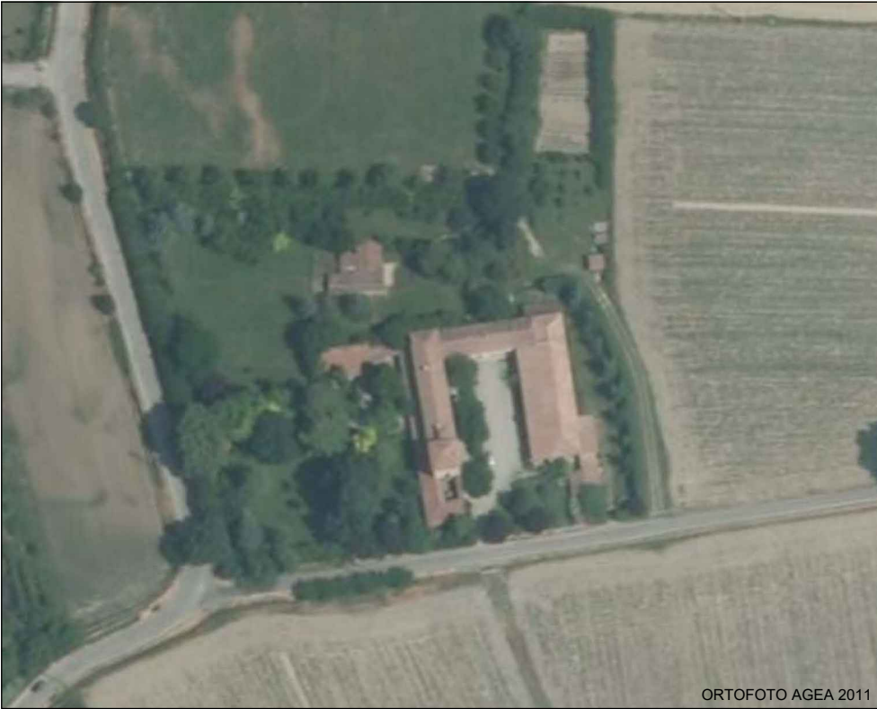
EDIFICI STORICI-CULTURALI E TESTIMONIALI: LAMPUGNANA
