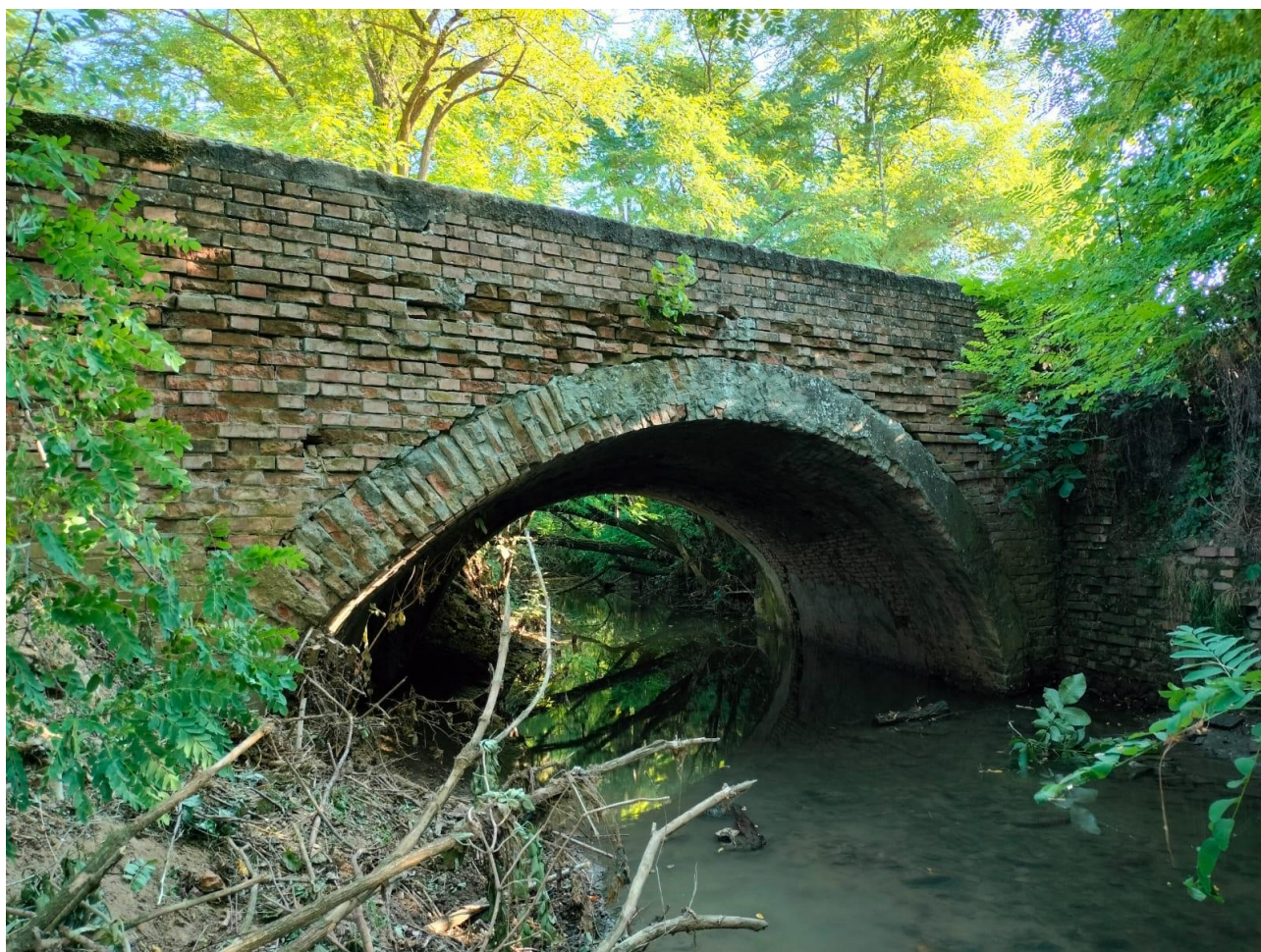
Foto 5 - Vista da sud del Torrente Loggia e del ponte carrabile esistente
