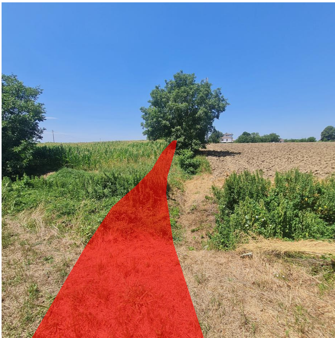
Foto 5 - Vista da est del Rio Lurone in corrispondenza della passerella ciclopedonale
