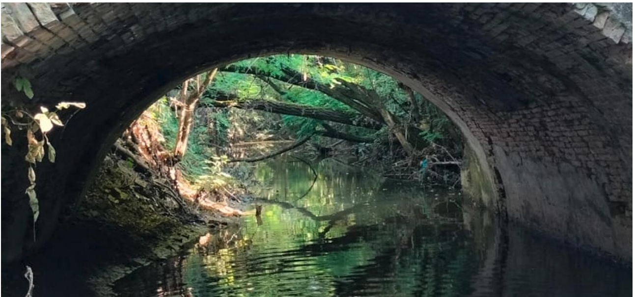
Foto dell'alveo del Torrente Loggia
