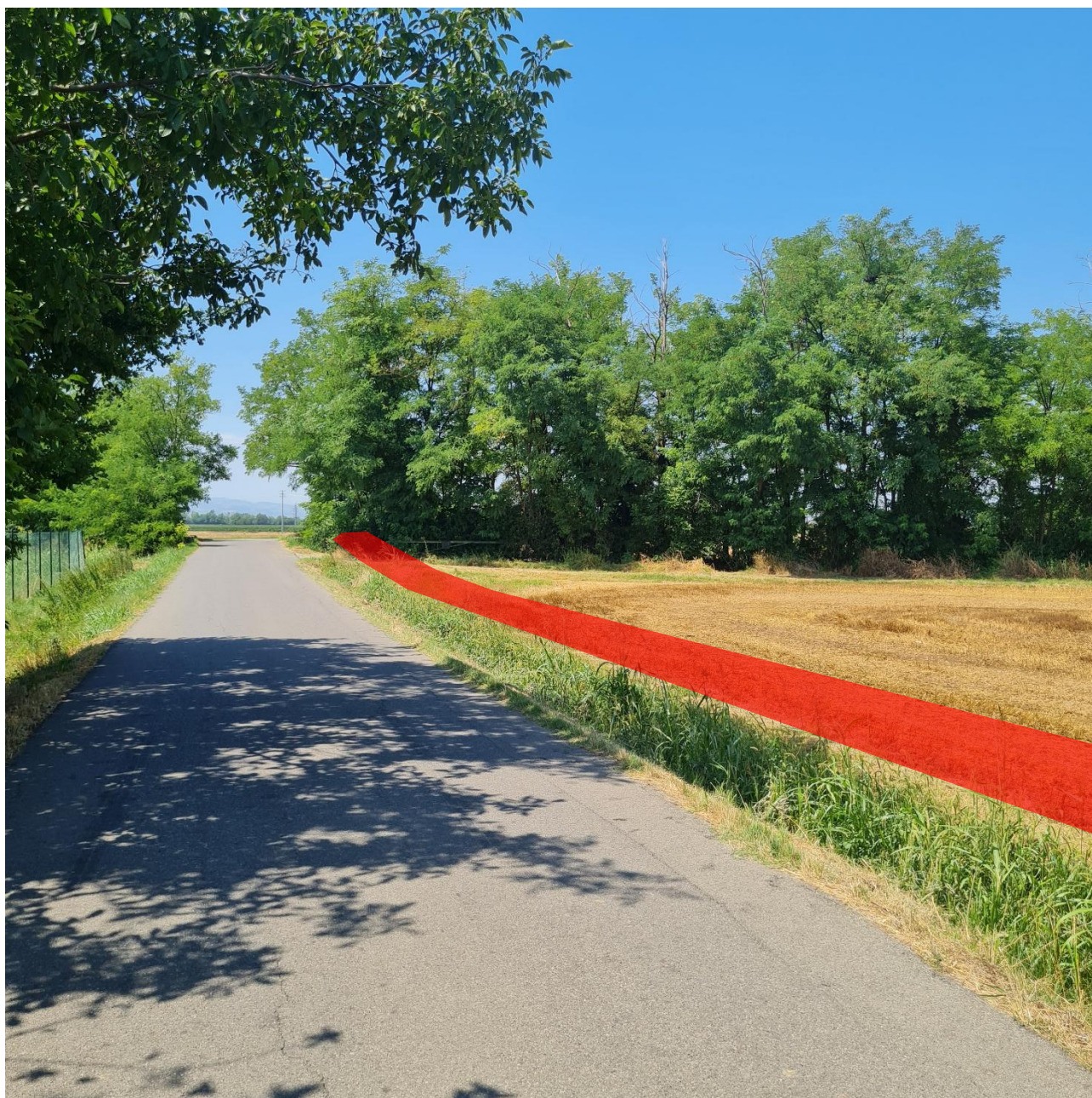
Foto 3 - Vista da est del Torrente Loggia
