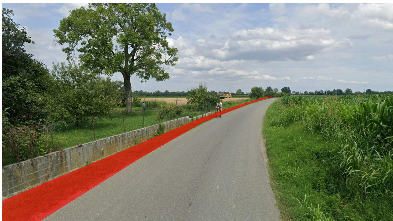
Foto 4 - Vista da ovest dell'area di intervento
