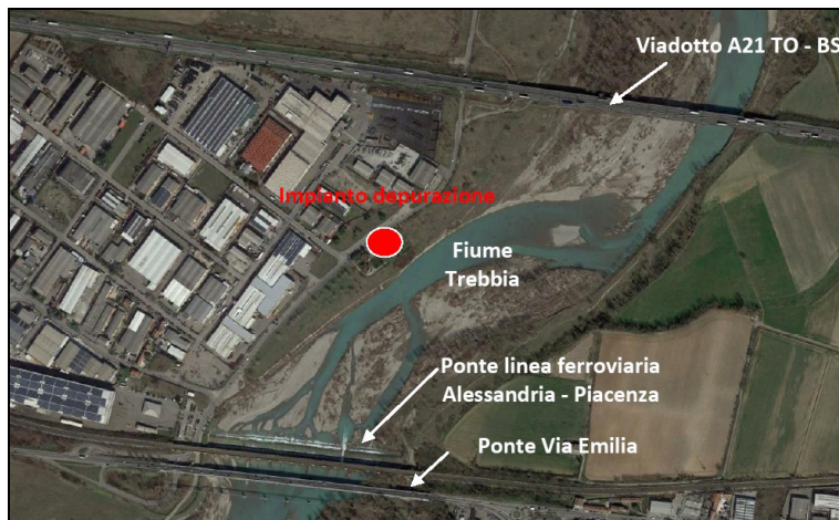
Figura 14. L'impianto di depurazione, situato a Calendasco
