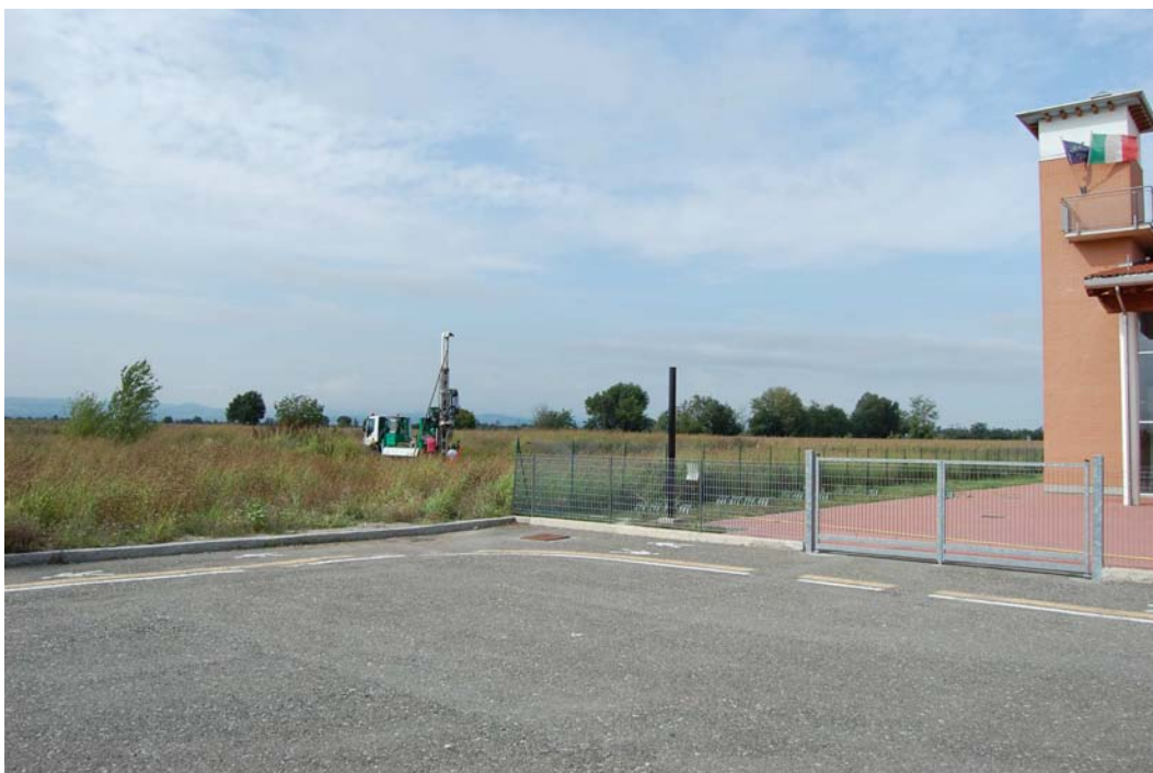
Fasi dell'esecuzione del sondaggio a carotaggio continuo
