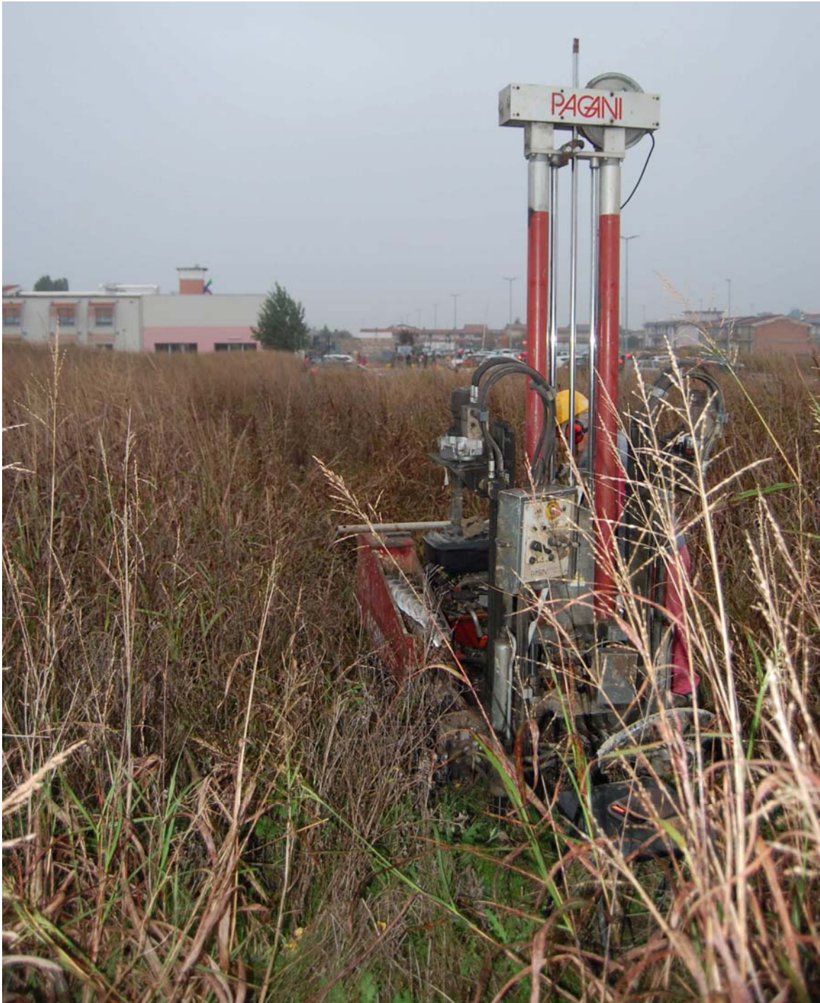
Fasi dell'esecuzione della prova CPT2; sullo sfondo la scuola elementare di San Nicolò
