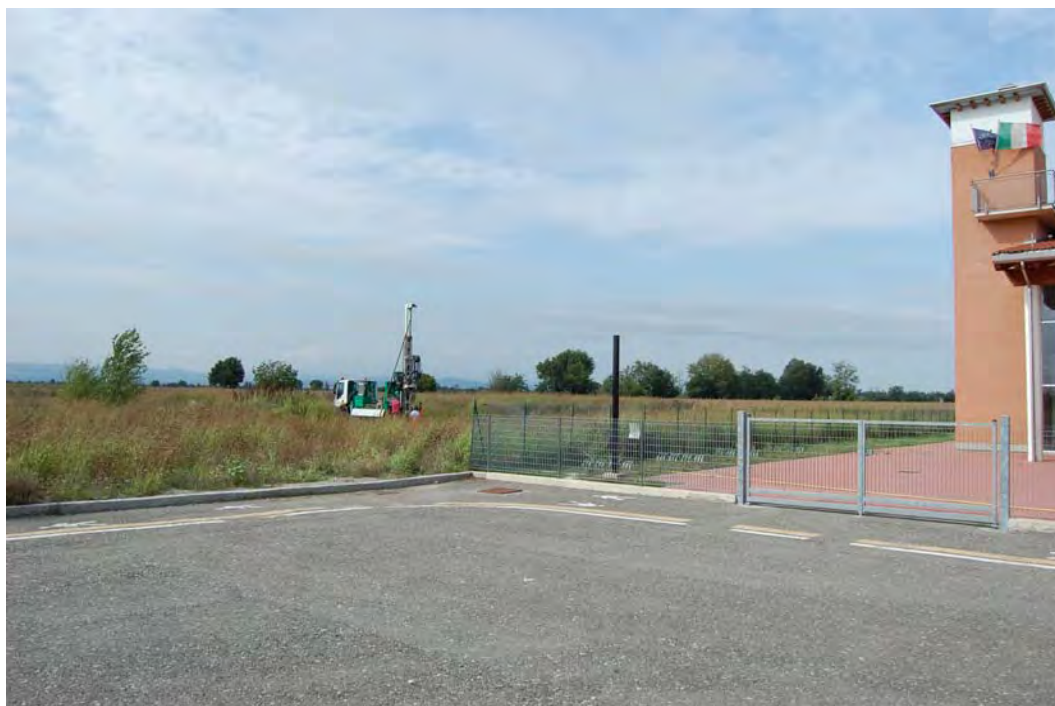
Fasi dell'esecuzione del sondaggio a carotaggio continuo
