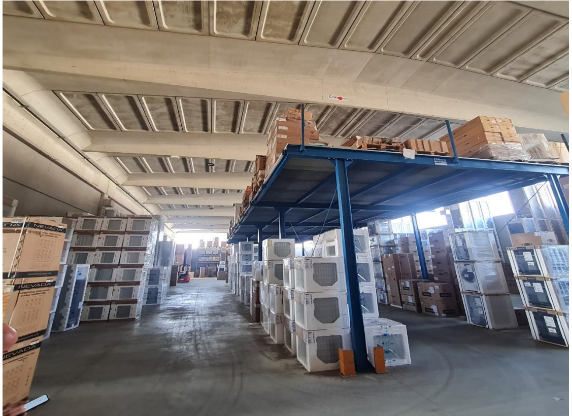
Interno deposito Delta Inox Srl
