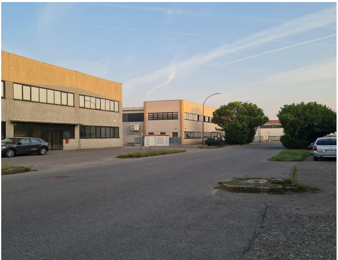
Panoramica Fabbricati (mapp.1054 e mapp.1647) da via Bergamaschi
