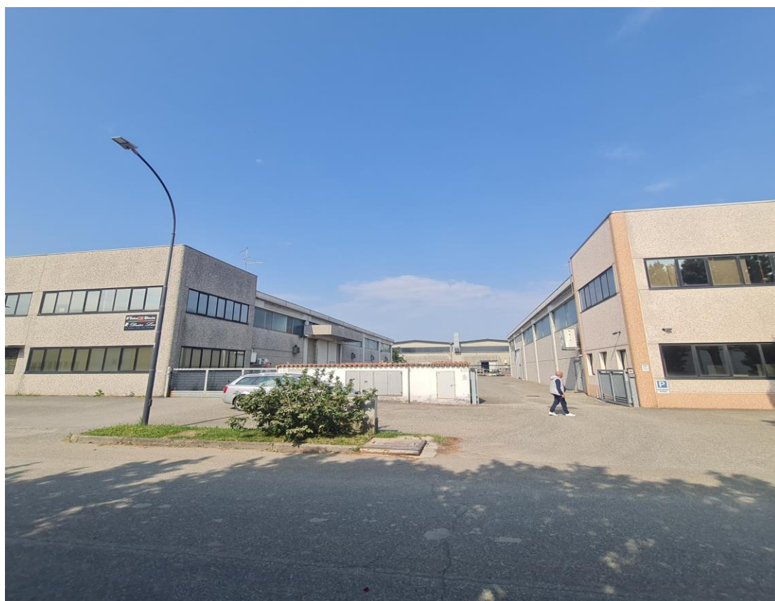
Area oggetto d'Intervento per nuova struttura di Collegamento tra i due Capannoni
